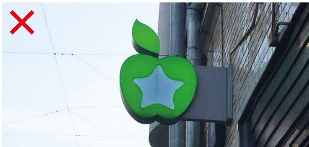
Конструкция кронштейна скрыта за обшивкой.
